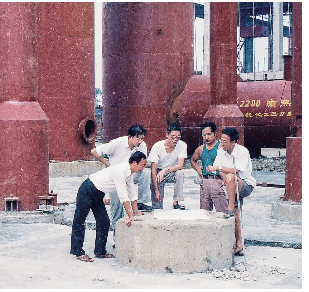
▲1999年9月,德阳生产厂区,几名工程技术人员在年产8万吨合成氨、13万吨尿素技改工程现场,商讨转化工程施工方案。 罗建一 摄
